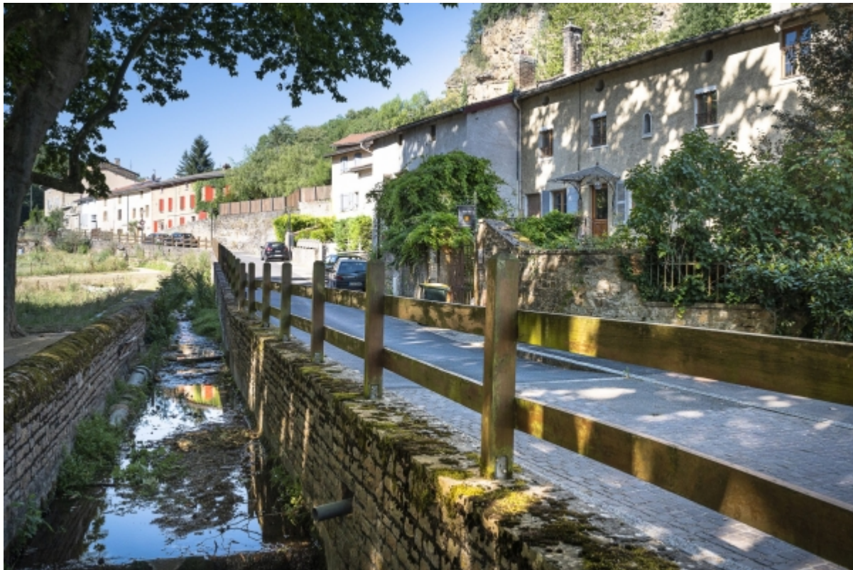
Le ruisseau Le Thoux, le long du chemin des Carrières à Curis-au-Mont-d'Or © Métropole de Lyon // Thierry Fournier
